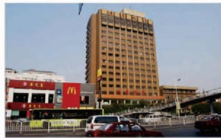
沈阳辽展饭店项目
