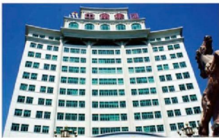
中南集团总部大楼
